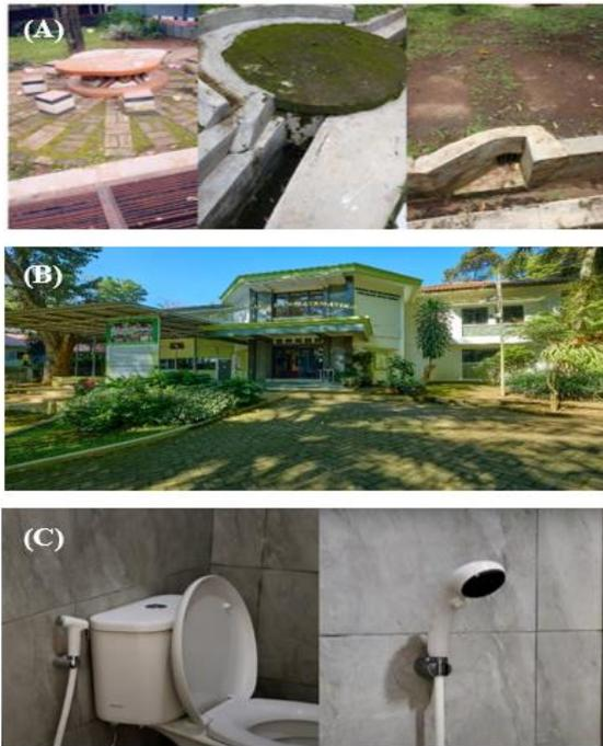
**Gambar 1.** Konservasi air yang sudah dilakukan (A) sumur resapan, (B) penggunaan paving blok, (C) peralatan hemat air *double flush*, *jet shower*, dan *shower* di asrama mahasiswa
