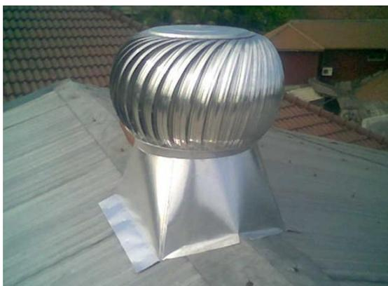
Gambar 1. Photo ventilator angin yang terpasang diatap suatu bangunan
