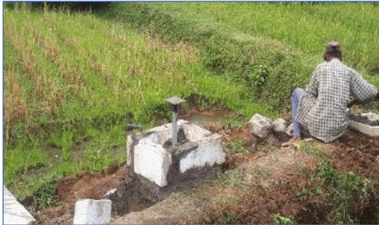
Gambar 21 Pemasangan Dudukan Panel Surya
