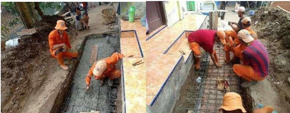
Gambar 5. pembesian dan pengecoran beton pelat penutup septik tank
